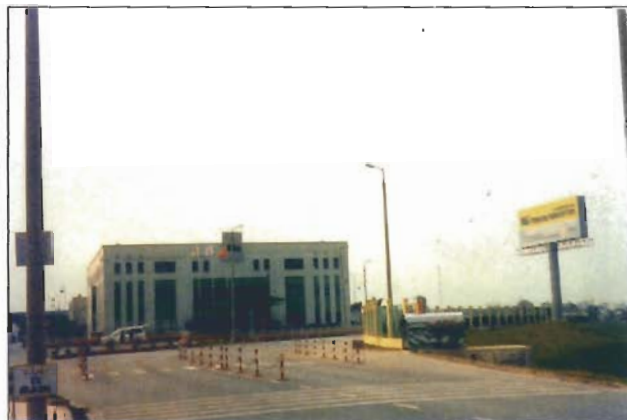
Khu công nghiệp Bắc Thăng Long huyện Đông Anh - Hà Nội
